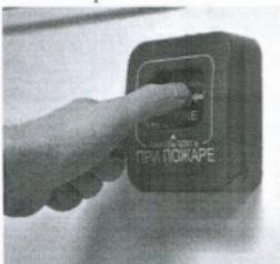
Пожарный извещатель служит для подачи сигнала о пожаре.
